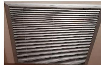
Ci-dessus : volets d'extraction de fumées (systématiquement en hauteur) et volets d'amenée d'air (systématiquement en zone basse)
